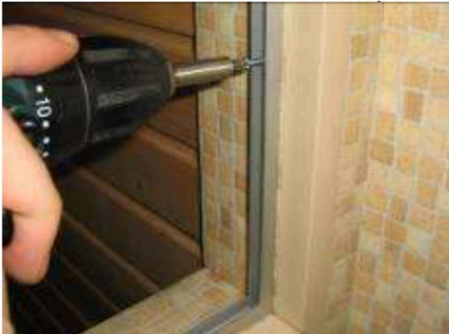
5. Befestigen Sie das obere und den unteren U-Profil an die türseitigen Befestigungslöcher (in der Mitte des U-Profils, siehe Abbildungen 4 und 4.1).
