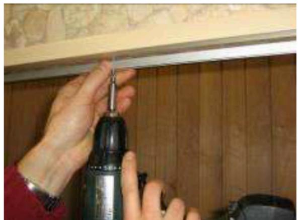
6. Versichern Sie dass die Schraubenköpfe im Innern des U-Profils nicht herausragen(Abbildung 5).
