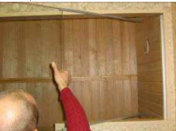
10. Drehen Sie die U-Profile mit der Glasscheibe auf einer Ebene mit der Saunatur. Stellen Sie sicher, dass das vertikale U-Profil, der obere und untere U-Profil ausgerichtet sind (Abbildung 7).
