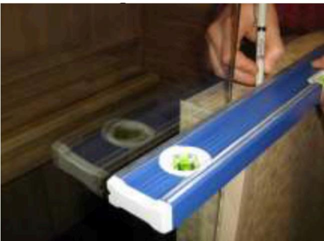
4. Stellen Sie die Glastür mit den Scharnieren gegen die Wand. Versichern Sie dass die Tür senkrecht steht und befestigen Sie die Scharniere mit Schrauben. Markieren Sie gegebenenfalls die Befestigungspunkte, bohren Sie Löcher, stecken Sie Dübel in die Löcher und befestigen Sie die Scharniere mit Schrauben.
