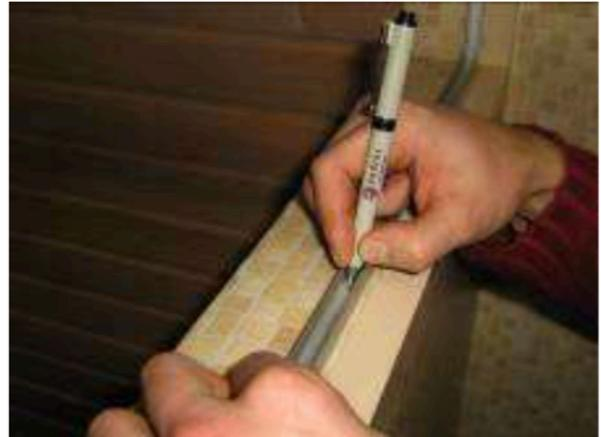
4. Befestigen Sie das vertikale U-Profil (Abbildung 3).
