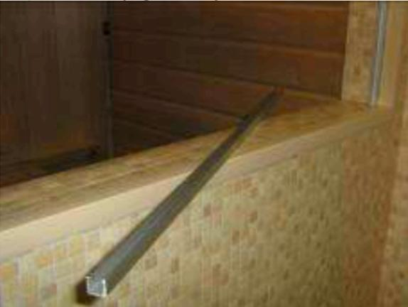
9. Schieben Sie die Glasscheibe vorsichtig zwischen die U-Profile (Abbildung 6.1). Achtung! Die Glasscheibe nicht ganz gegen die Wand schieben. Stellen Sie sicher, dass die Befestigungslöcher für die Schrauben auf der Seite des oberen und unteren U-Profils offenbleiben (Abbildungen 8 und 8.1).
