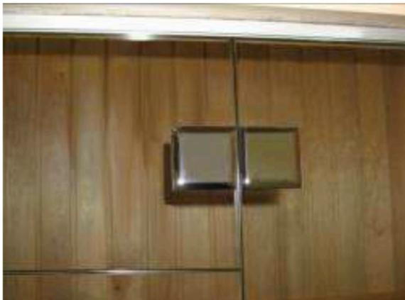
13. Überprüfen Sie, dass zwischen der Glasscheibe und der Tür ein Abstand von 3-5 mm besteht (kann durch Verschieben der Glasscheibe eingestellt werden, siehe Abbildung 10).
