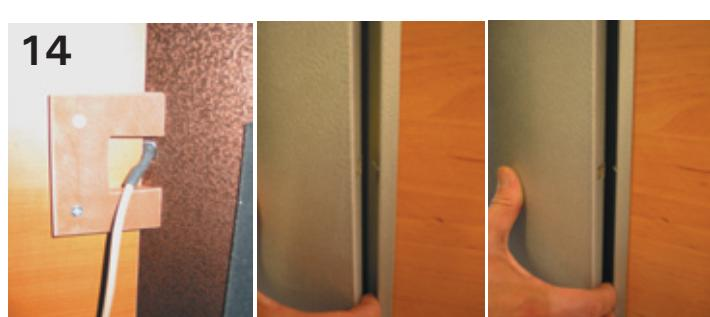
Закрепите корпус блока управления. Рис. 15. Установите электронную плату, вставив ее в корпус. Рис. 16. Установите переднюю крышку блока управления. Рис. 17.
