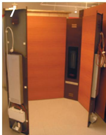
Установите на место блок крыши. После этого установите металлические держатели между блоком крыши и стеновыми элементами. Удалите защитный пластик с держателей. Рис. 8 и 9.
