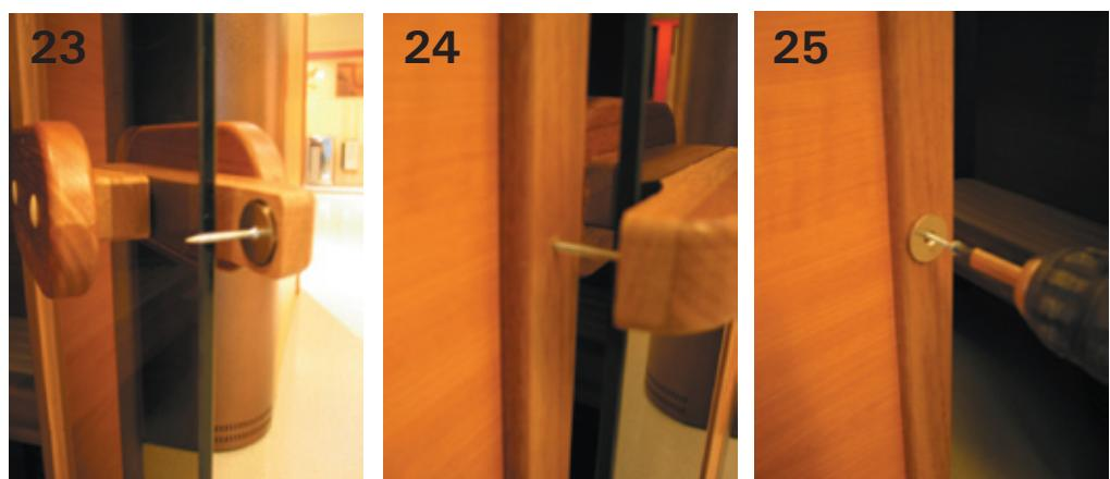
Установите дверную ручку, обратившись к отдельным инструкциям. Соедините винт и прокладку с магнитом и отметьте место для крепления прокладки. Отсоедините винт и прокладку от магнита и закрепите прокладку винтом на косяке коробки. Рис. 23, 24 и 25.
