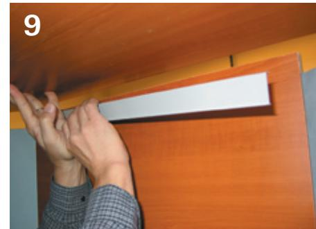
Прикрепите металлические уголки к блоку крыши с помощью шурупов (4 x 13 мм). Рис. 10.
