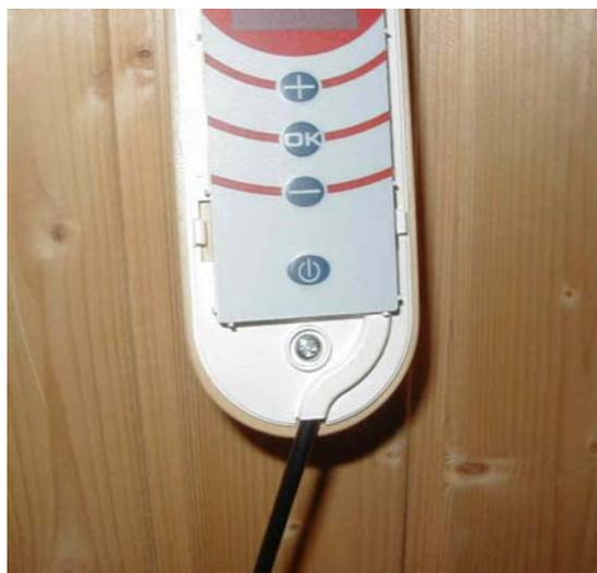
Прорежьте пластиковую заглушку у торца декоративной накладки для выхода кабеля. Оденьте накладку на корпус пульта управления. Она защелкивается на клипсах.
